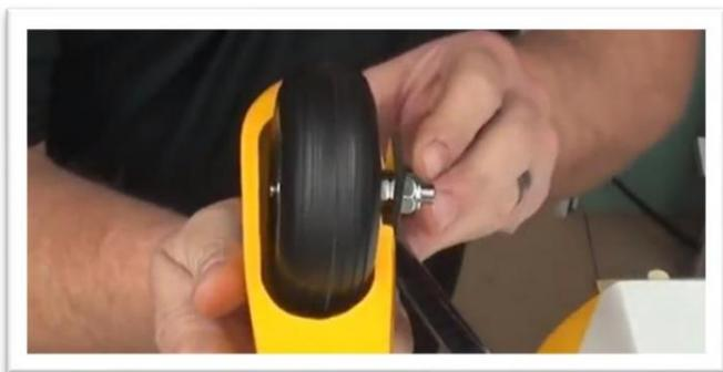
Installez la roue et les colliers de roue sur l'essieu permettant à la roue de tourner librement.
